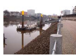
Tiefer 1 und 2 / Weser km 366,2 rechts PKW / Lande- und Parkmöglichkeit
